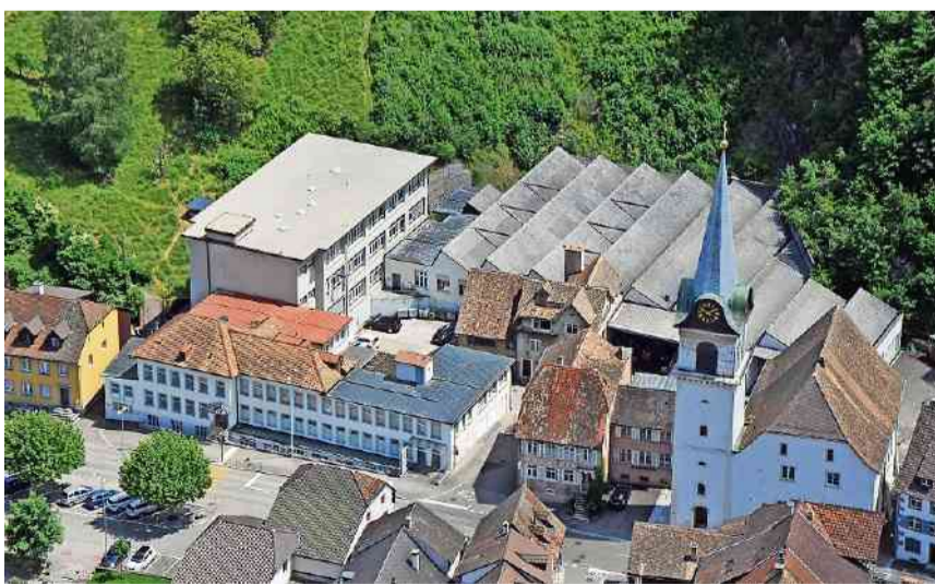
«Villa» im Hof wird zurückgebaut, die anderen Gebäude werden saniert. ERNST MORY
